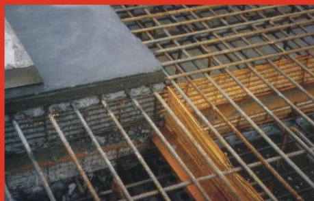
MSL Typ/type SWF02 nach dem Betonieren/ after concreting
