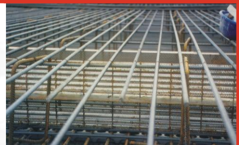
MSL Typ/type STzF1 mit Eckaufschlag links/ with corner addition left
