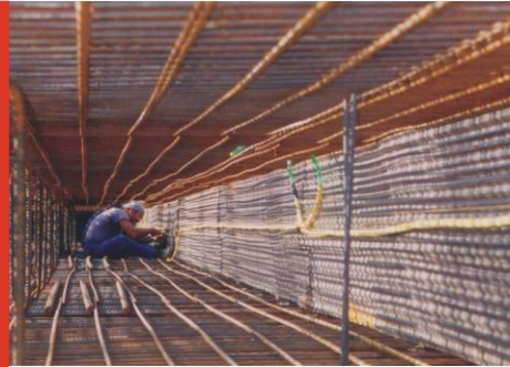
MSL Typ/type SW 0,50 Einbau durch die Fa./Installation by EK Bauwerkabdichtung GmbH
