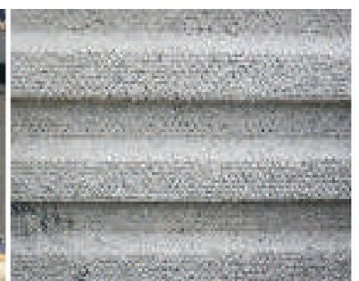
Die **MSL**-Trapezprofilierung entspricht den Anforderungen der Schubkraftübertragung in Fugen nach DIN 1045-1 (verzahnt).
