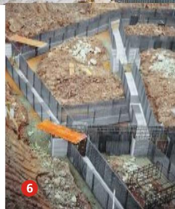
Eckausbildungen lassen sich problemlos durch bauseitiges Einschneiden und Verrödeln mit Draht auf der Baustelle herstellen. Foto 1, 3 und 4 zeigt einen Bauabschnitt, bei dem die Schalung teilweise bereits ausbetoniert, mit Erdrreich angefüllt oder noch freistehend ist.
