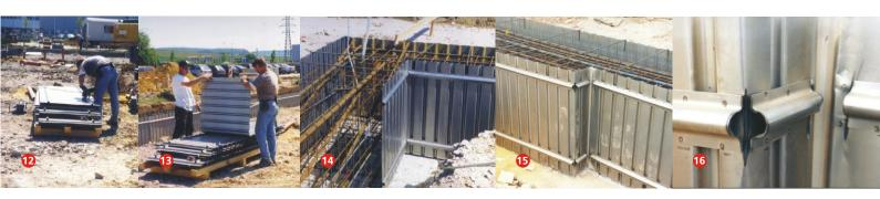
Formteile, wie z.B. Innen- oder Außenecken, werden mit dem Winkelschleifer durch Einschnitte in die Querprofile und Abbiegen in die gewünschte Form hergestellt siehe Fotos von 12 bis 16
