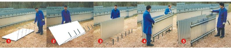
1 Das Schalelement wird flach auf die Außenseite gelegt, danach werden die unteren Bügel in die Profilierung eingehängt. 2 Nach dem Kippen der Schalung um 90 Grad steht diese ohne zusätzliche Hilfe auf den unteren Bügeln. (Danach könnte bereits die Bewehrung eingebracht werden). 3 Das Schalelement steht. 4 Das 2. Element wird eingehängt. 5 Zuletzt werden die oberen Steckbügel eingehängt. Dadurch werden die Seitenteile im vorgegebenen Abstand fixiert.
